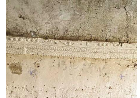
διατήρηση γύψινης σουβάντζας στον πρώτο όροφο
